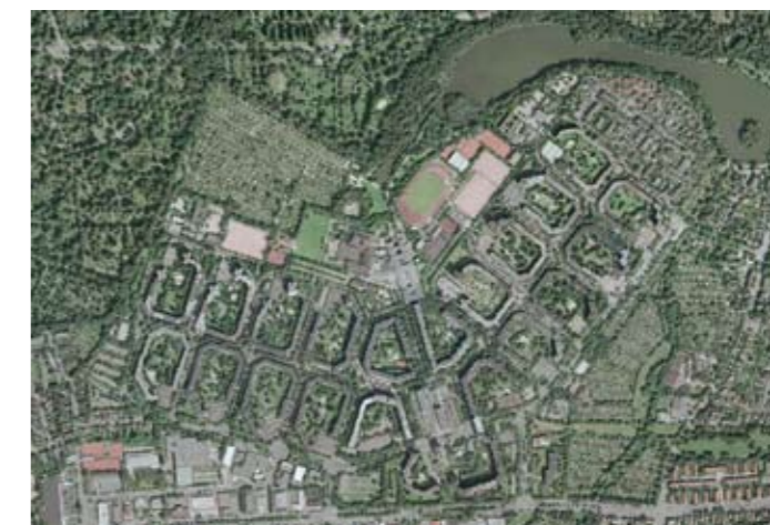
Luftbild: Das Quartier liegt im Nord- osten innerhalb der Stadt
