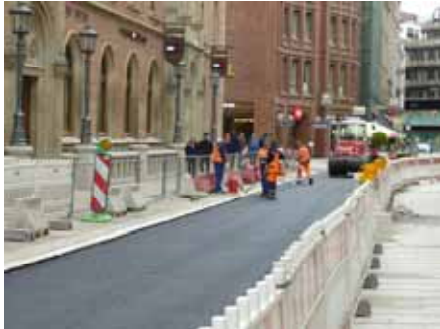
Neugestaltung des Passagenviertels in der Hamburger Innenstadt läuft auf Hochtouren, Foto: Heiner Schote, Handelskammer Hamburg
